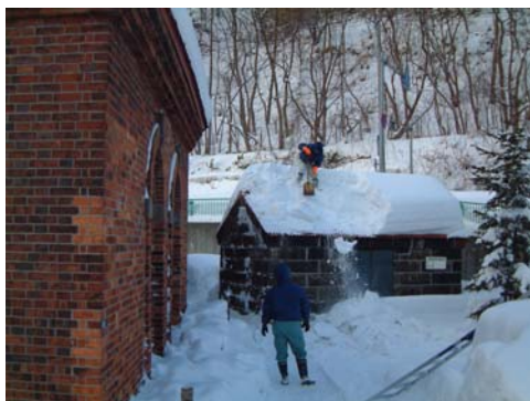
重要文化財施設の除雪作業
