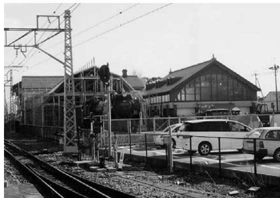
建設中のヘリテージセンター「北陸線電化記念館」
