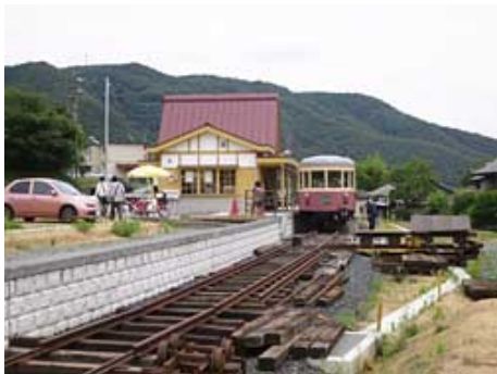
4 両対応化に向けて着発線延伸工事
