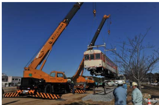
東日本大震災被害の復旧作業
