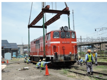
本体・台車一体で引き上げる
