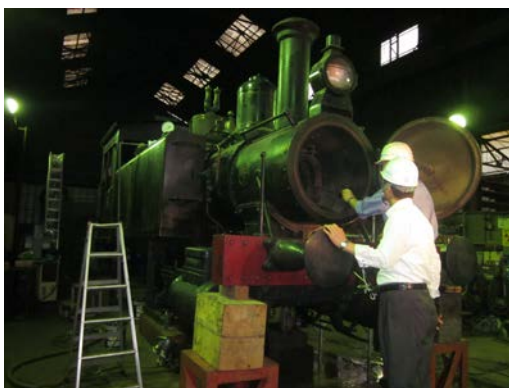
ボイラーの修理現場（大阪）
