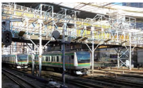
東海道本線横浜駅 内海川跨線人道橋 (昭和 5 年・1 9 3 0)
