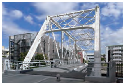
現・霞橋 旧新鶴見操車場跨線橋を移築保存
