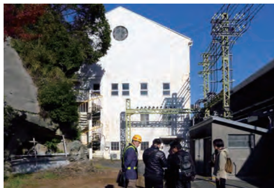
旧湘南電鉄瀬戸変電所（昭和 4 年・1 9 2 9）外観
