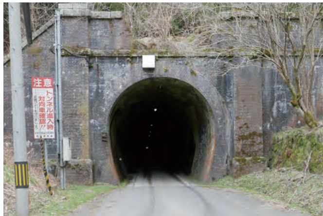
旧北陸本線山中トンネル（南越前町）
