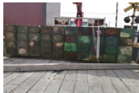
▲構内の枕木で特に損傷が激しかった車庫に向かう線路の枕木を 40 本交換した。交換は保存愛好会と駅舎スタッフで実施。
