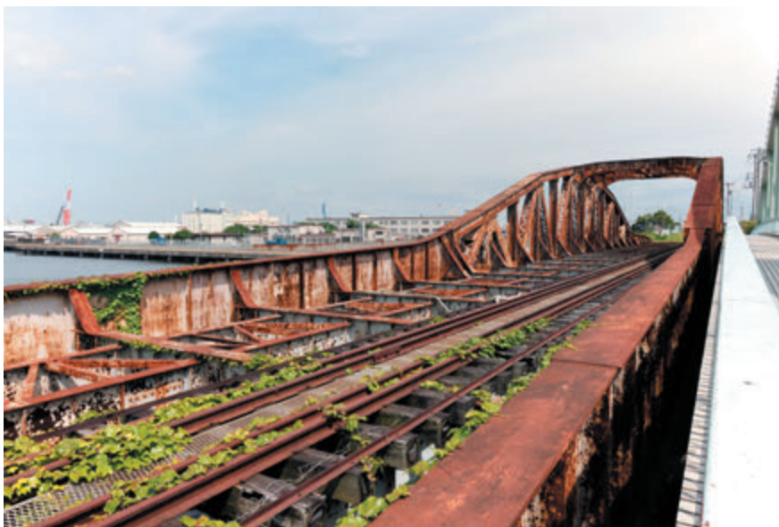
リベットと溶接を併用した我が国初の瑞穂橋梁
