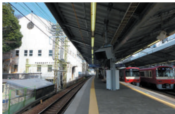
昭和 4 年（1929）建造の瀬戸変電所
