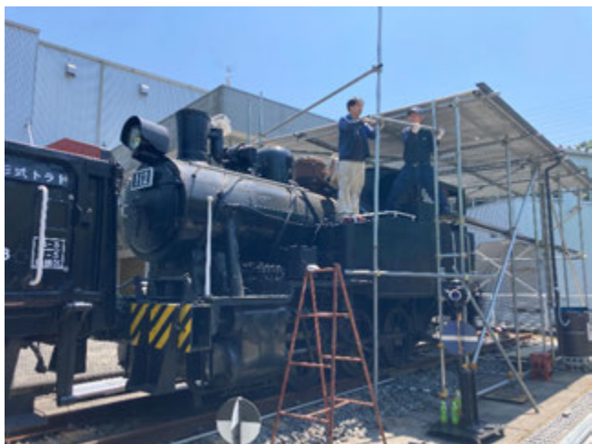
動態化へ向けて蒸気ドーム取り外し
