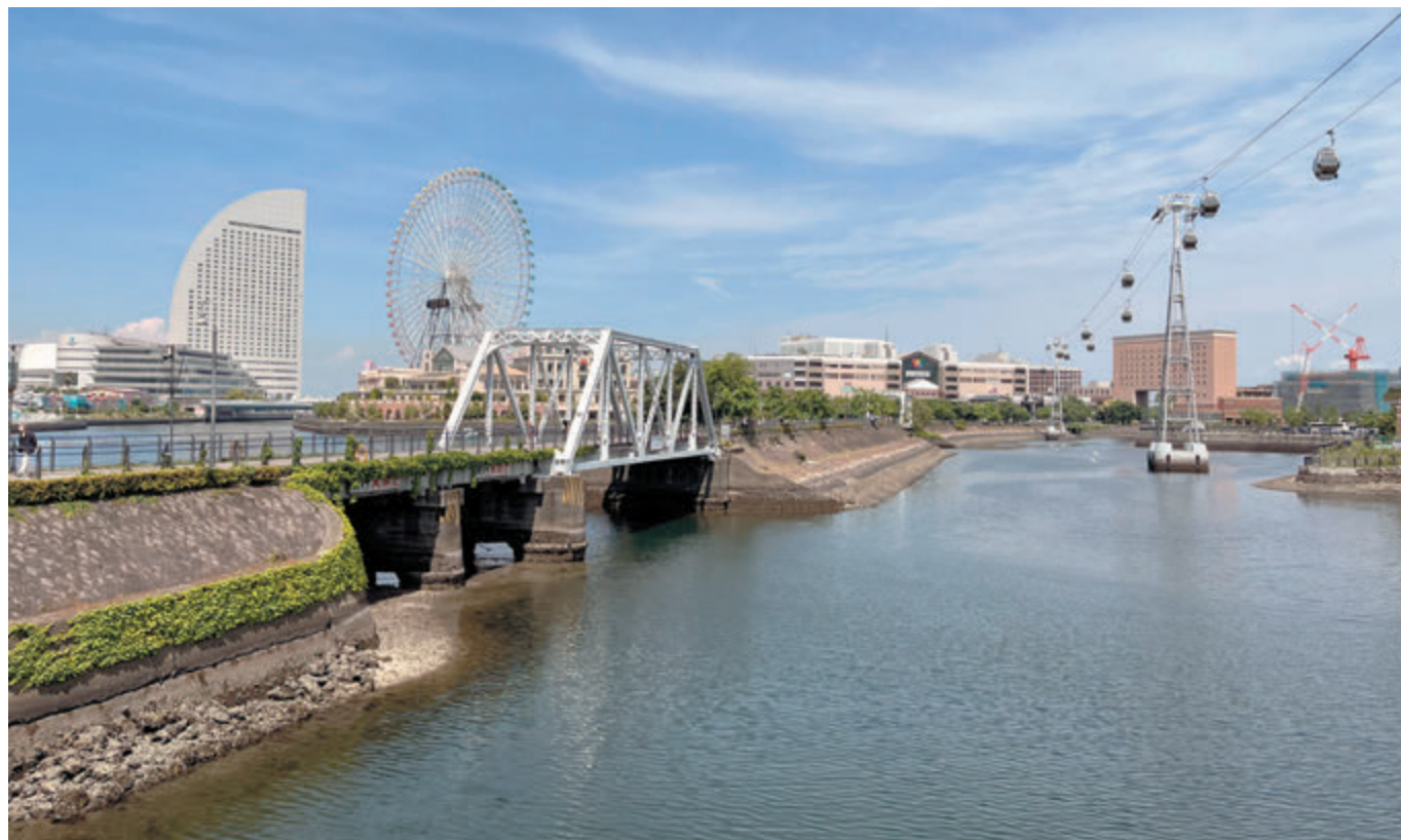
横浜市認定歴史的建造物 汽車道
