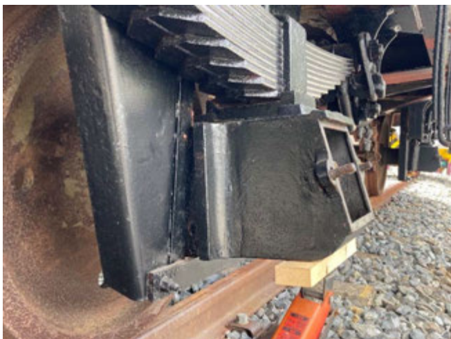
小ジャッキを使って軸箱を傾け抜取する
