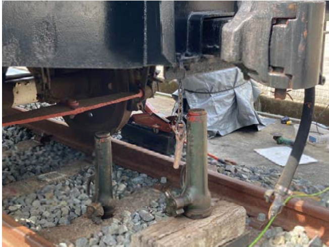
ビームジャッキを2機入手できました
