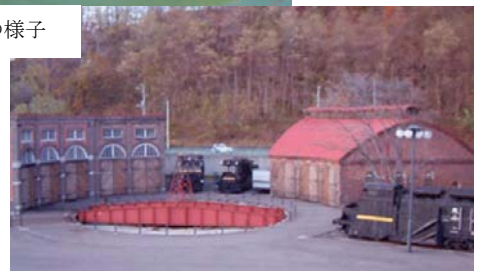
(右) 機関車庫 1 号 (左) 機関車庫 3 号 (中央) 転車台
