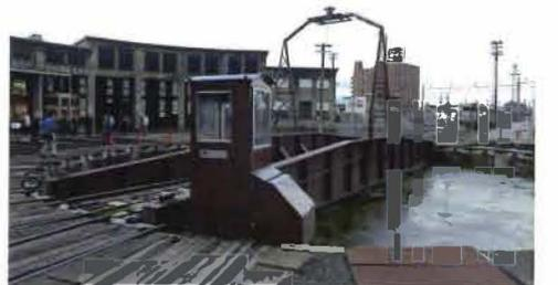
1930(昭和5)年に設置されたという60ft(約18.24m)下路プレートガーダー式の転車台。1931(大正6)年に標準設計された「G2-1」形で、手前の二輪式転車台電動牽引機は1954(昭和29)年福島製作所製の二代目。
