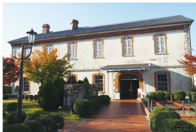
現存する日本最古の駅舎「旧長浜駅舎」
