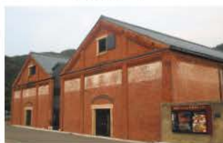
敦賀赤レンガ倉庫
