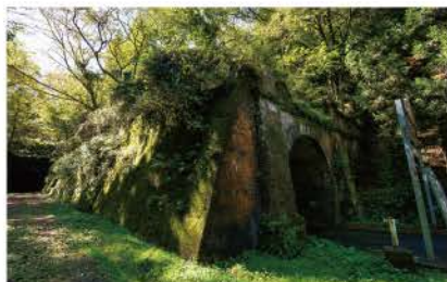
山中トンネル
