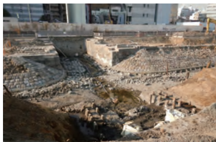
▲都心の一角に姿を現した高輪築堤の遺構。海側の傾斜した石垣の石積み
