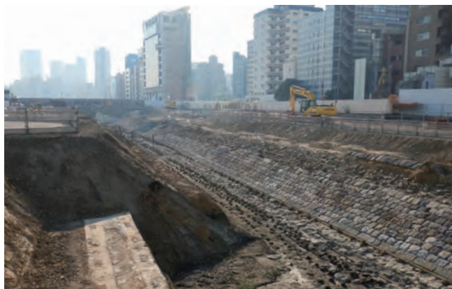
▲都心の一角に姿を現した高輪築堤の遺構。海側の傾斜した石垣の石積み
