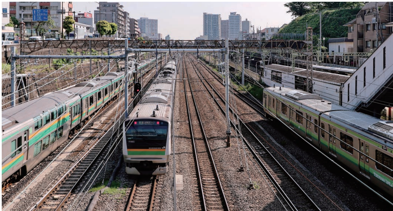
横浜駅東側の掘割を貫く東海道本線を中心とした線路群。ここはもと丘陵地で、切崩し線路を敷いた。土砂は海上に線路の路盤を造成する埋め立てに使われた(撮影 田中光一／2022年5月)
