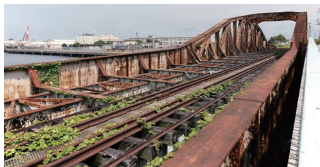
アメリカ軍の施設がある瑞穂埠頭に向かう専用線に架かる瑞穂橋。1934年の鉄製で溶接技術が採用された貴重な建造物
