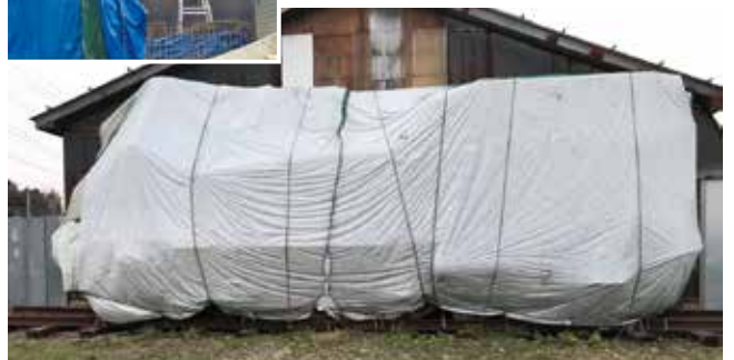
▼2023年4月17・18日に102号機被いカバーをブルーシートからテント地に取替工事を実施しました
