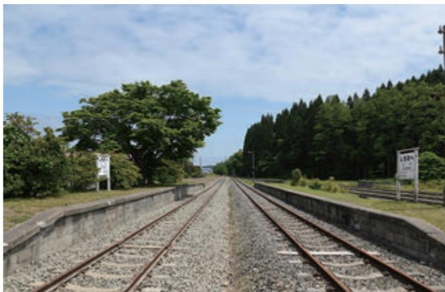
▲構内すべての線路のPC枕木化作業が完了し、1、2番線とも車両が入線できるように
