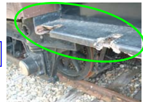
デッキ板修繕
