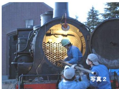
写真2 煙管・ステー管を挿入する様子
