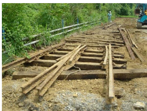
柵原駅構内から分岐器を運び出しました
