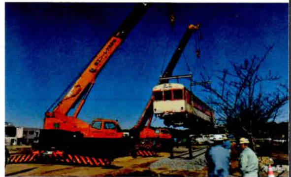
東日本大震災被害の復旧作業
