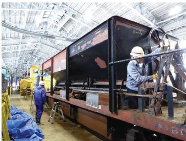
▲小坂鉄道ホキ909(ホキ800形)は、昭和36年(1961)に国鉄浜松工場で製造された古老車輛。まずは、痛んだ塗装を落とすことから始める。
