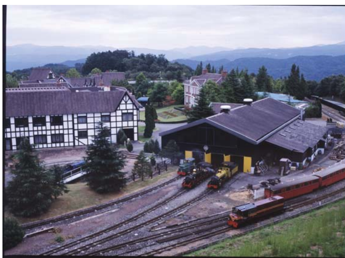
機関庫 全景写真
