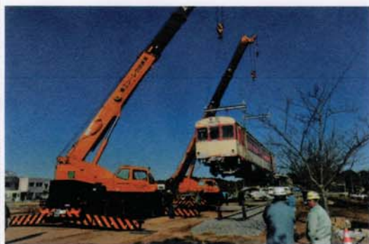
東日本大震災被害の復旧作業
