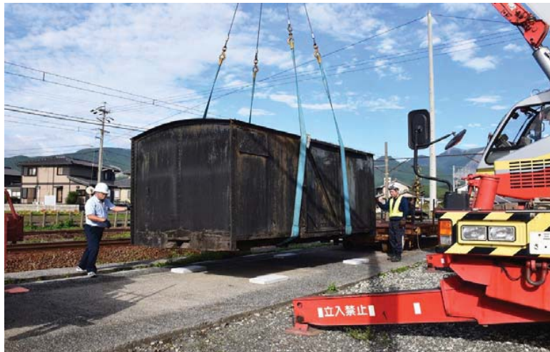
貨物鉄道博物館へ搬送される 旧関西鉄道貨車 2017年9月21日
