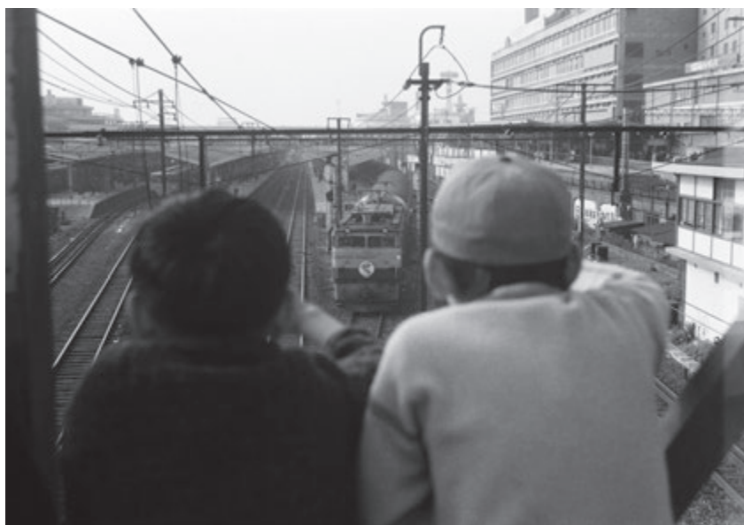
特急はやぶさ（横浜駅内海川跨線橋 昭和42年11月26日）
