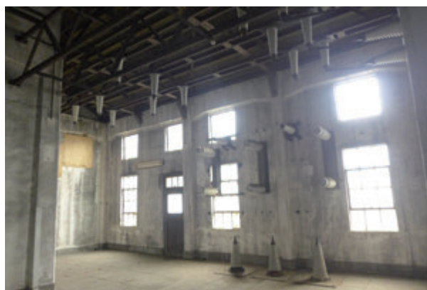
内部は建設当時の面影をよく残す
