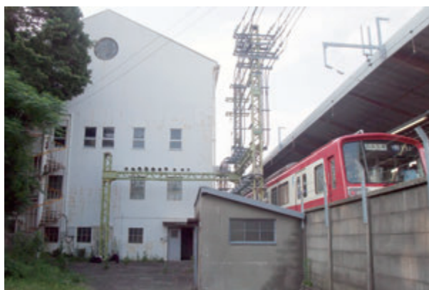
旧湘南電鉄瀬戸変電所は、金沢八景駅に隣接
