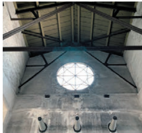
瀬戸変電所 バラ窓
