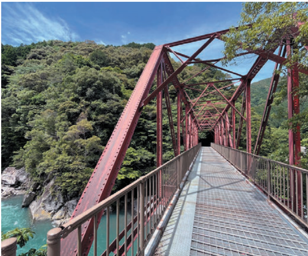
旧魚梁瀬森林鉄道施設 明神口橋
